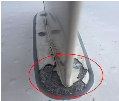
Korosi pada ELT antenna baseplate
