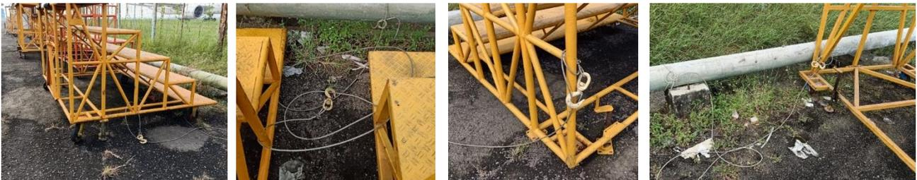
Figure 2. Contoh Pemasangan Sling Cable pada Tangga Kerja
